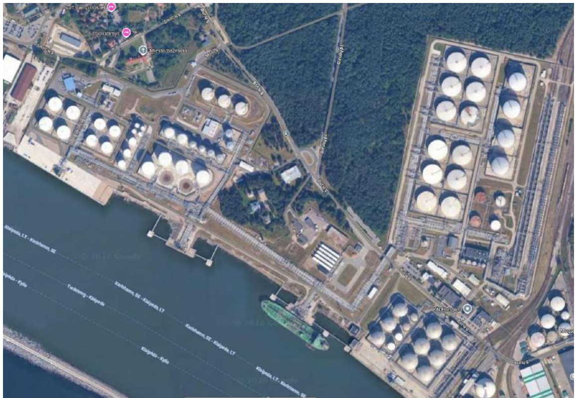
3.1.4 pav. Ortofotonuotrauka (2026 m. situacija) su įgyvendintais KVJU krantinės Nr. 1 rekonstrukcijos I-o etapo statybų sprendiniais
